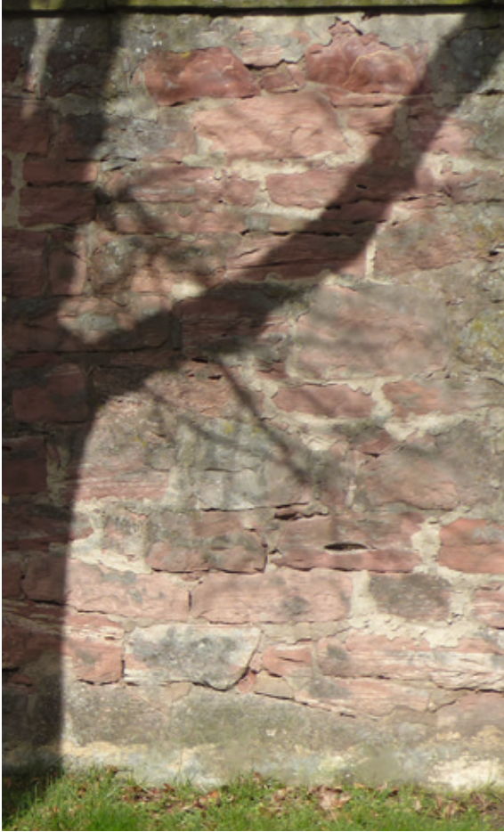
Die Mauer bietet Schutz zum öffentlichen Raum
