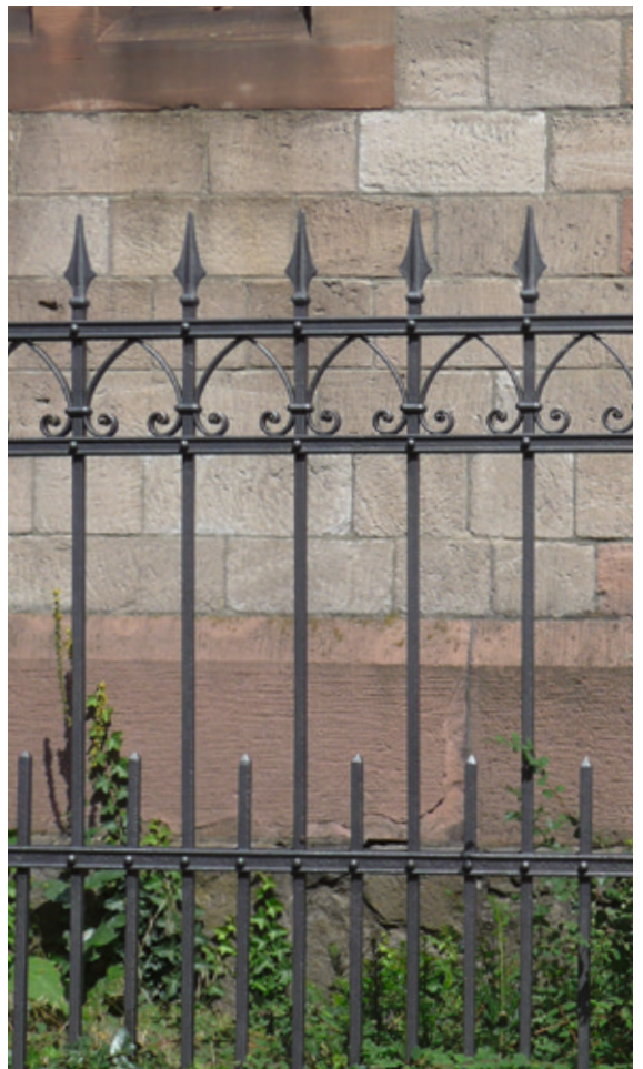
Eisenzäune ermöglichen Einblicke auf das Grundstück
