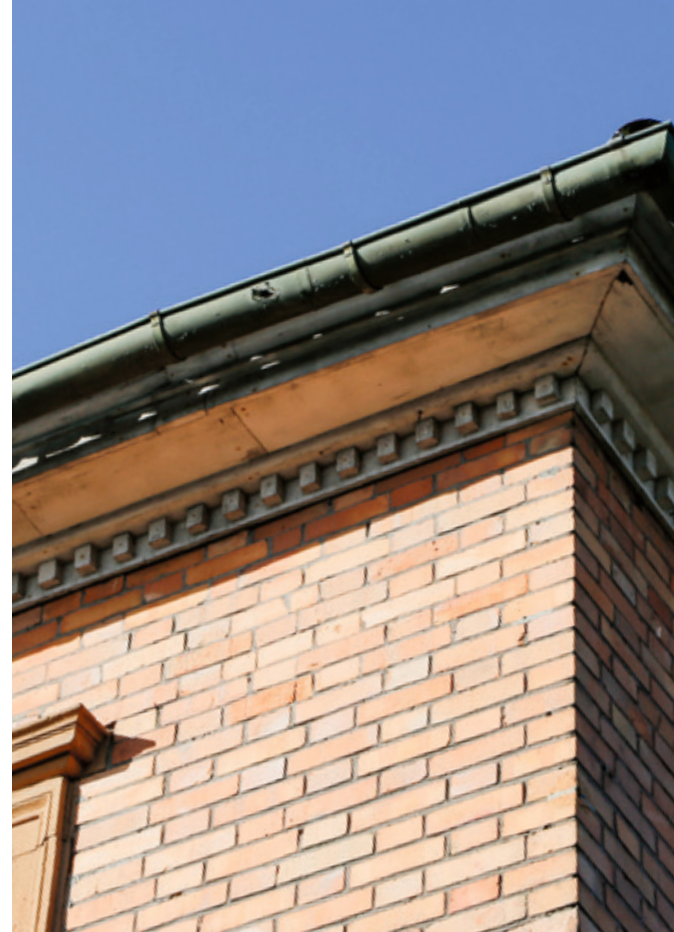
Schlichte Dachabschlüsse mit Zahnleiste, eingemörteltem Ortgangziegel oder Dachfries sind hier prägend
