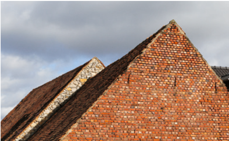
Schlichte Dachabschlüsse mit Zahnleiste, eingemörteltem Ortgangziegel oder Dachfries sind hier prägend
