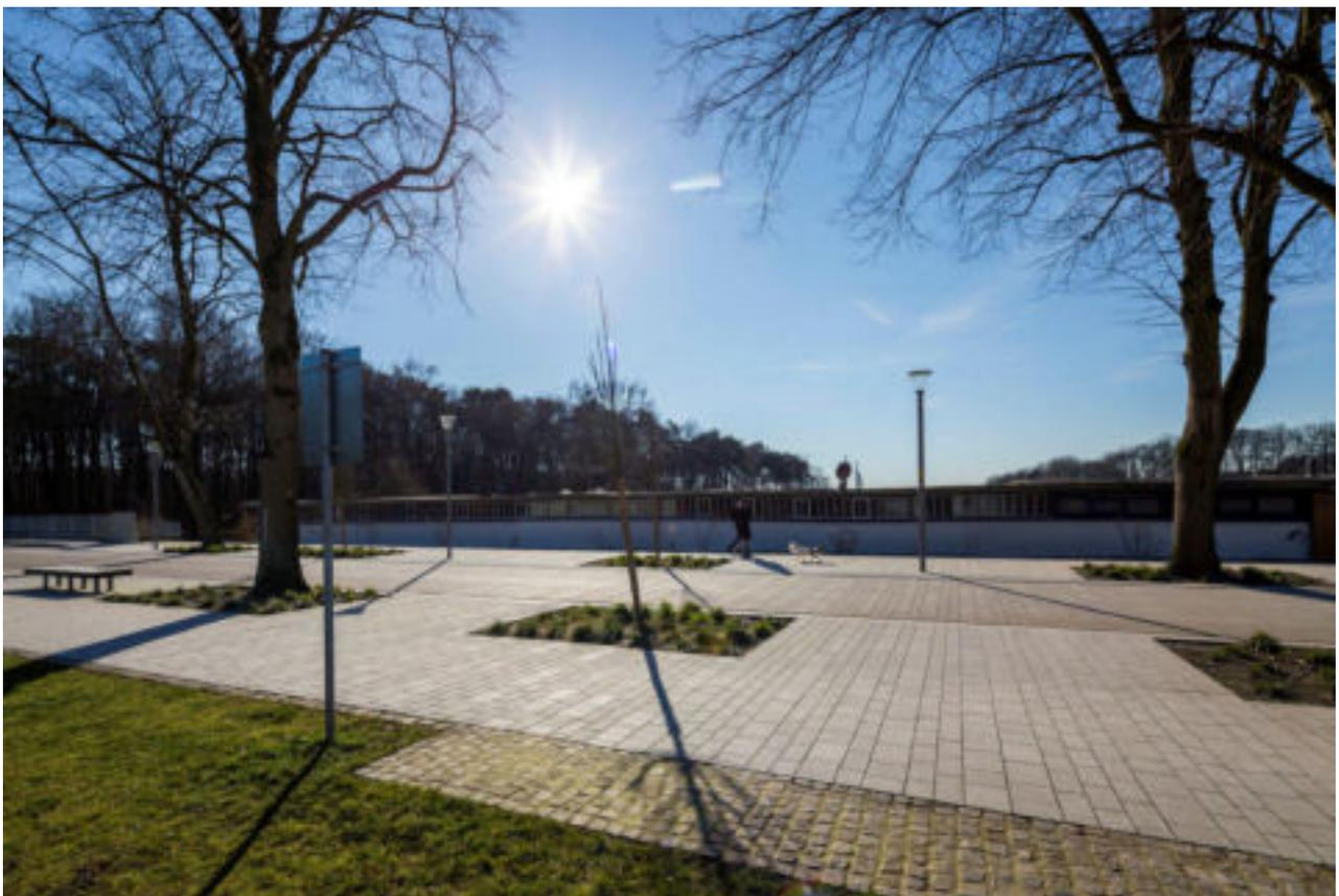
Beispielbild zur Pflasterverlegung im Reihenverband mit unterschiedlichen Reihenbreiten
