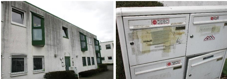
Abb. 11: Raiffeisenstraße 2 (Gewerbepark Rodgau) Umnutzungstendenzen von gewerblicher zu Wohnnutzung
